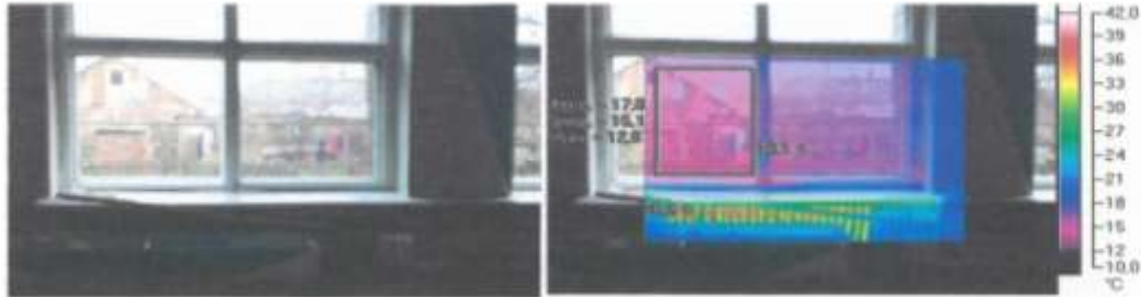
Рисунок 3.3 - Тепловтрати через низький опір вікна у приміщенні 11 центральне вікно
